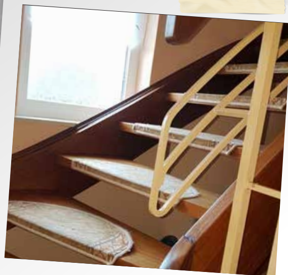
Urok lat 70-tych na klatce schodowej.
