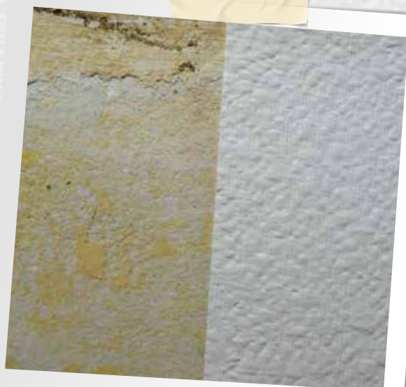
Na spękane miejsca nakłada się po prostu okładzinę tapetową.
