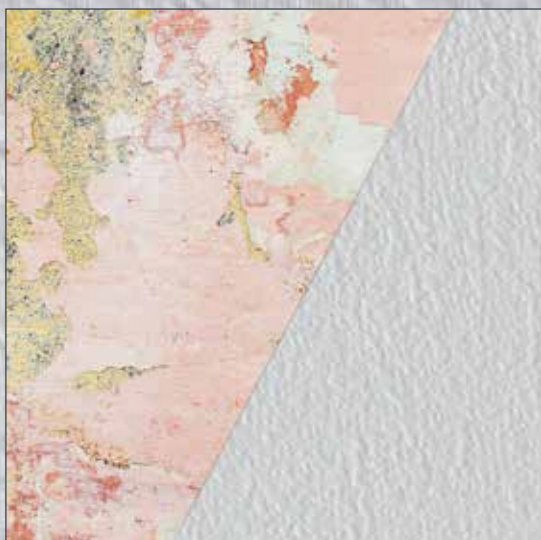
Stare tapety: usunąć luźne fragmenty, zagruntować i wytapetować.
