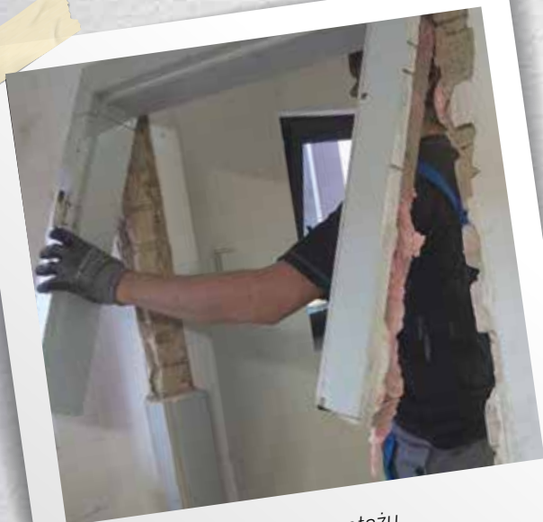
Właściciel Julian przy demontażu ościeżnicy.
