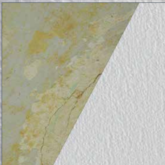
Rysy: usunąć luźne fragmenty, zagruntować, pokryć okładziną tapetową.
